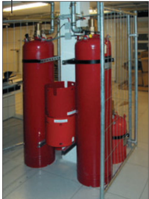
SAPPHIRE® Gaslöschanlage SAPPHIRE® gaseous extinguishing system
